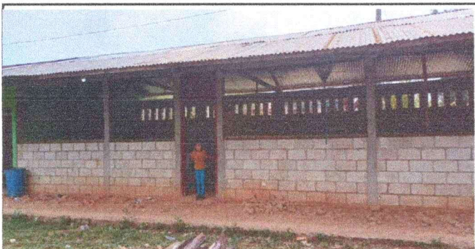
Foto 11. Módulo 2, Sustitución de ventanas de las aulas de Primero A y B. Debido a que el forro ha sido únicamente con malla.
