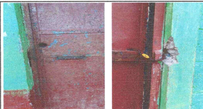
Foto 12. Módulo 2, Sustitución de Chapas de las puertas del aula de Sexto Primaria, debido a que las cerraduras son inservibles y no brindan una seguridad en cuanto a los mobiliarios que resguardan.
