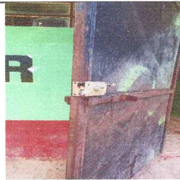
Foto 6: Módulo 1 Sustitución de puerta, como se aprecia en la imagen la puerta se encuentra averiada, con la chapa inservible por lo que se dificulta cerrarla.
